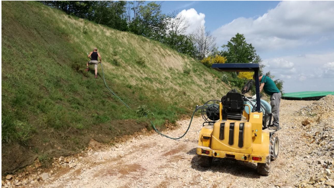
Figura 16 - Interventi di idrosemina su scarpate.
