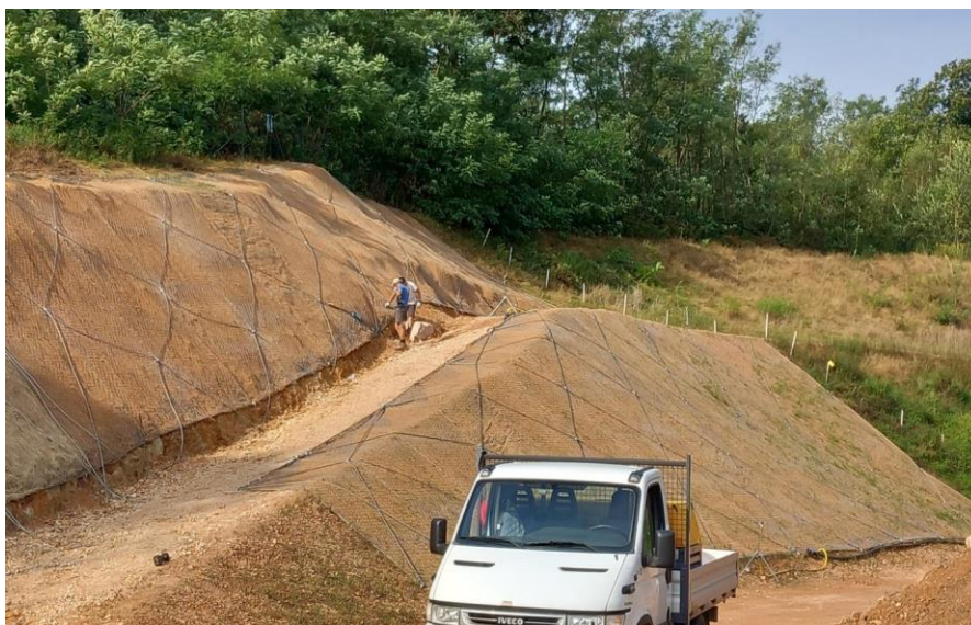
Figura 15 – Georete successivamente fissata con cavi di acciaio.
