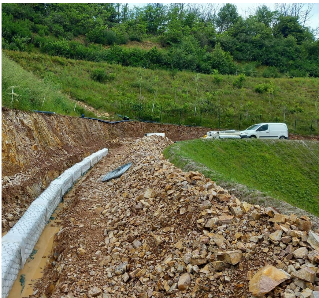
Figura 11 - Settore W Scavi e posa dreni per captazione acque meteoriche per evitare erosioni.
