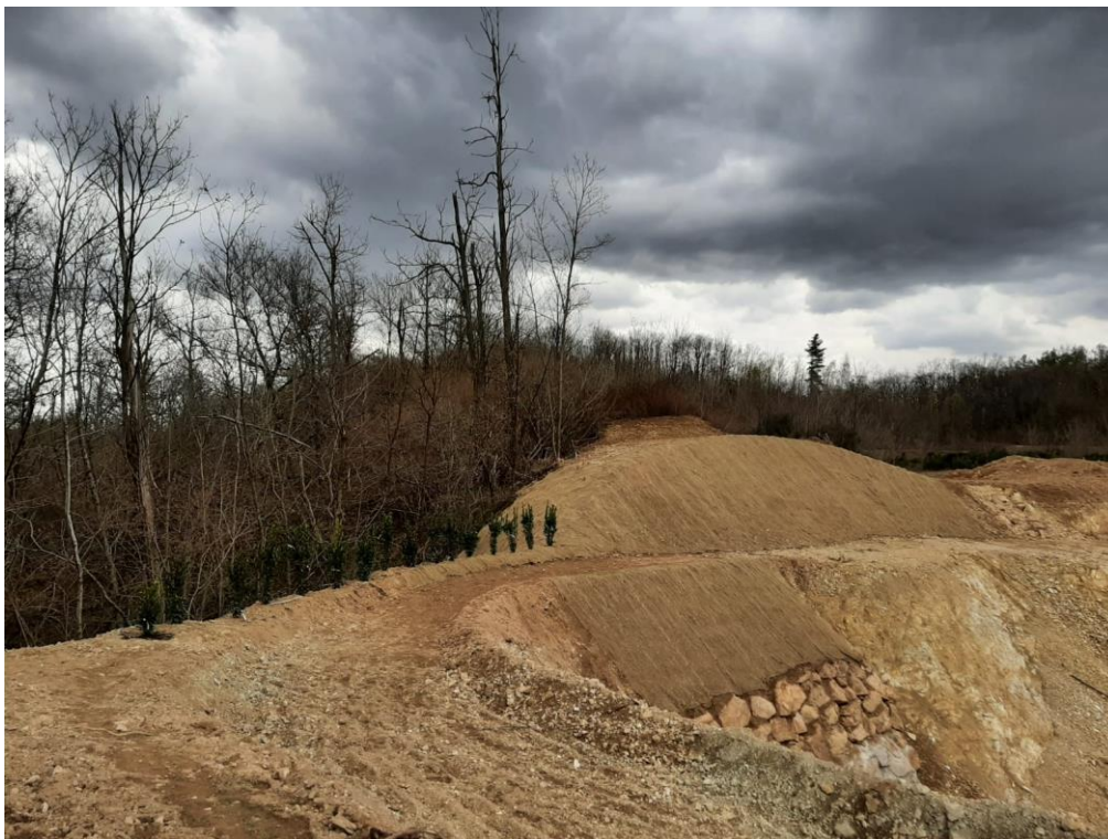
Figura 12 - Operazioni di ripristino morfologico a monte del bacino di decantazione e di ripristino vegetazionale con impianto siepe di Lauro nobilis e inerbimento mediante idrosemina a monte del bacino di decantazione.
