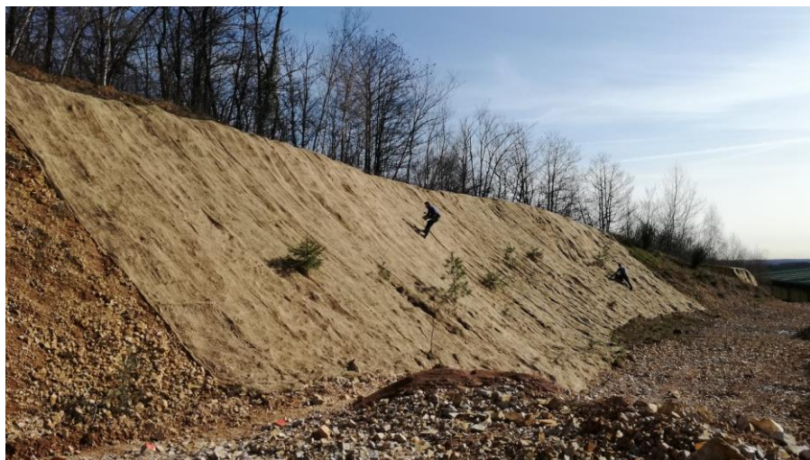
Figura 14 - Posa georete per inerbimento mediante idrosemina.
